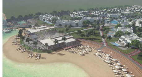
Rixos Hotel, KSA
